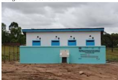
©latrine construites dans une école Dans la ZS de Ruzizi
