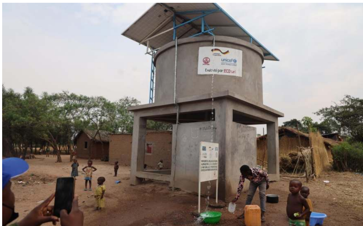
©forage doté du système photovoltaïque ZS de Ruzizi, photo AFPDE 2024
